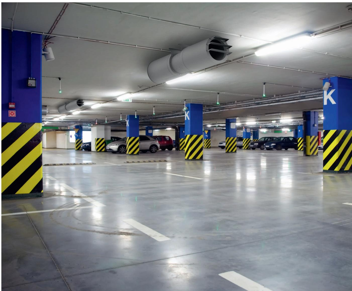
Rauchabzug ist ein komplexer Vorgang bestehend aus Rauchabführung und Frischluftzufuhr über ein Be- und Entlüftungssystem zur Sicherstellung einer sicheren Evakuierung von Menschen aus brennenden Gebäuden.
