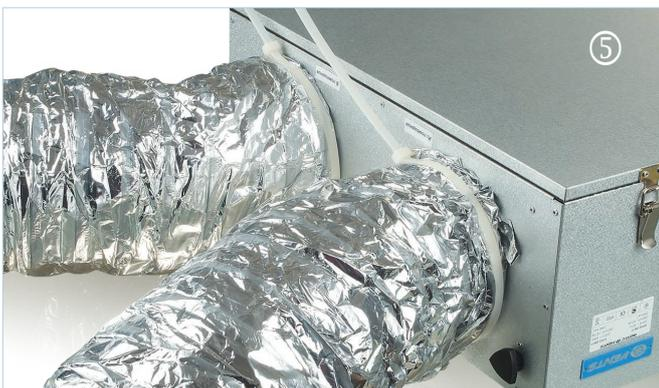
Затяните монтажные хомуты на внешнем рукаве теплоизолированных воздуховодов в месте их соединения с фланцами монтажного комплекта НМ Изовент.
