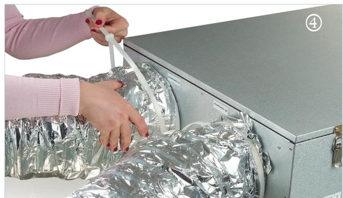
Наденьте внешние рукава теплоизолированных воздуховодов на фланцы монтажного комплекта НМ Изовент, плотно прижав их к корпусу вентиляционной установки и зафиксировав монтажными хомутами (входят в комплект поставки).
