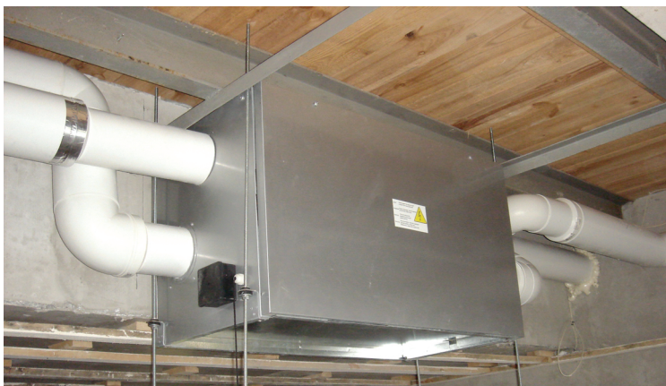
Рис. 3. Компактная вентиляционная установка
