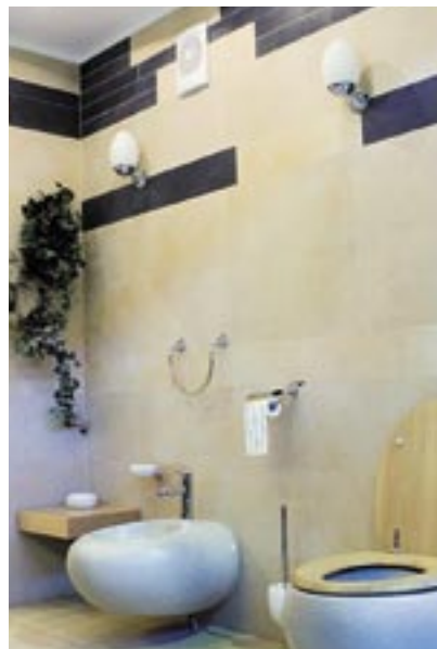
Санузел нуждается в отдельном вентиляторе для удаления влажного воздуха и запахов. Производительность вентилятора зависит от объема помещения. В санузле площадью 10 м 2 устанавливаем вентилятор «Вентс 125 МТН» с таймером и датчиком влажности
